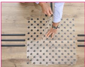
1- Positionner les gabarits et les clipsant entre eux (encoche prévue sur le gabarit transparent)
