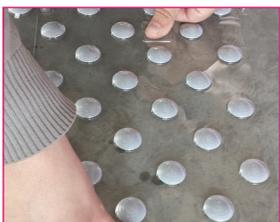
3- Les fixer au sol grâce à la bande adhésive positionnée sur le gabarit à cet effet.
